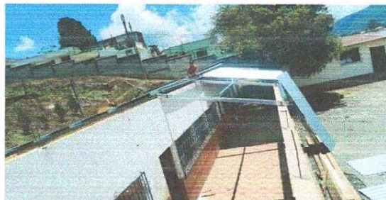
Foto 2: CAMBIO DE TECHO DE TRES AMBIENTES UNO DE COCINA Y DOS AULAS
