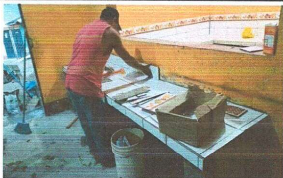
Foto 3: REMODELACION DE COCINA
